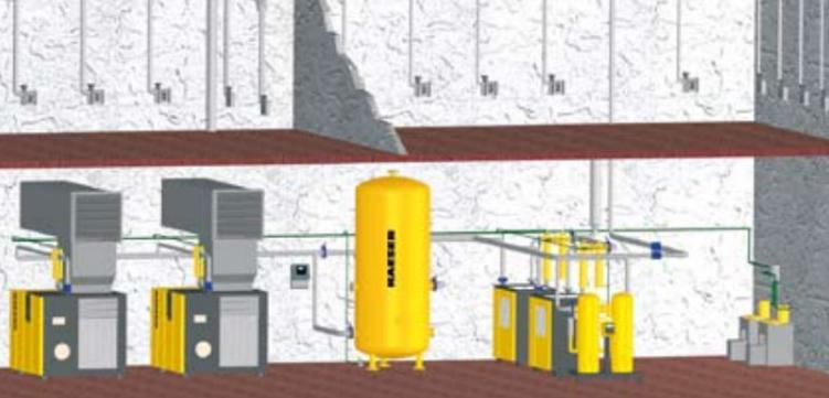
Photo 4: Station avec traitement de deux qualités d'air comprimé différentes
