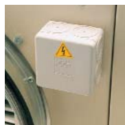
Boîte à bornes extérieures IP 55
