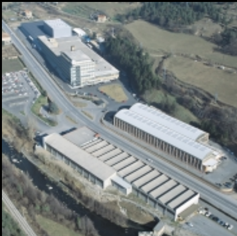
Fábrica principal en Ripoll (España). Main factory in Ripoll (Spain).
